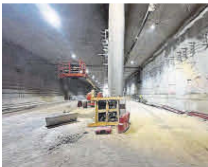
Ramal de salida hacia Boadilla. La parte derecha del túnel es para dirigirse hacia Boadilla del Monte.
