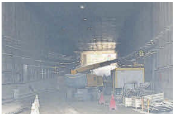
Rampa de entrada al túnel. Por aquí, en tan solo unos meses, entrarán los coches. «Va a ser un cambio espectacular para los vecinos y su movilidad», nos explican.
