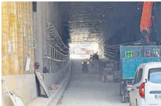
Rampa de salida del túnel. Más de 80.000 vehículos saldrán de este túnel a diario. El tráfico se reducirá hasta un 90 % en la superficie.
