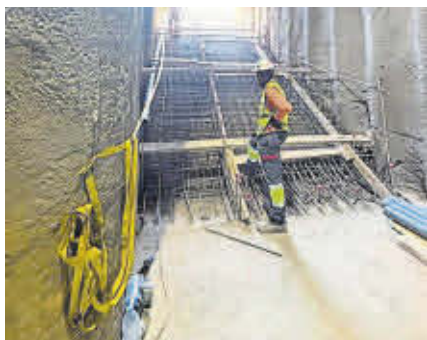
Salida de emergencia en ejecución. Cada 200 metros habrá una, y esta se encuentra todavía en obras. Son escaleras para 'huir'.
