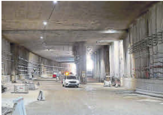
Ramal de salida hacia Yébenes. En la parte derecha de la imagen se puede apreciar este ramal, que será frecuentado por decenas de miles de vehículos a diario.
