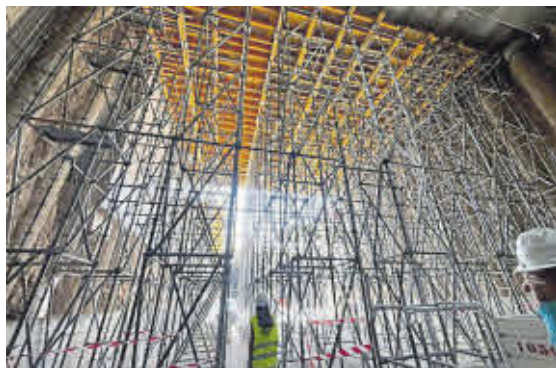
Sistema de cimbra. Es una estructura temporal que funciona como molde y soporte. Se coloca para aguantar el hormigón para cerrar el paso de la parte superior.
