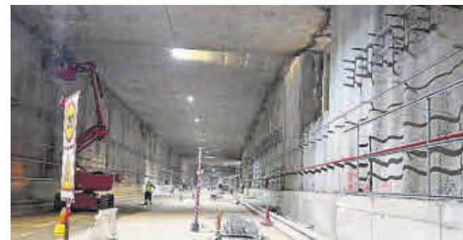
Cableado, sistemas... Los trabajos actuales se centran en colocar todos los sistemas para que el túnel funcione de manera correcta. Antes de su puesta en marcha, se ejecutarán diversas pruebas.
