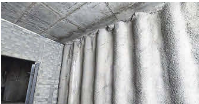
Los famosos pilotes. Las columnas con forma cilíndrica que se aprecian en la imagen son los pilotes, elemento fundamental en la obra del túnel de la A-5. Se han instalado en total «cerca de 6.000».
