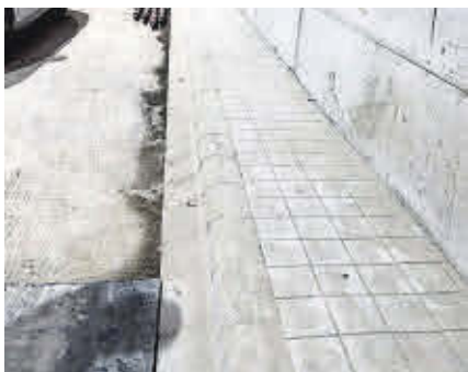
Acera para casos extremos. Ya se ha ejecutado una acera que se podrá usar en caso de accidente o emergencia.
